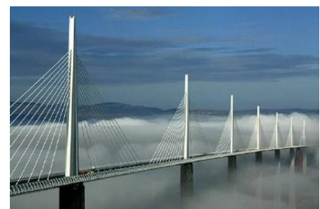
Viaduc de Millau
